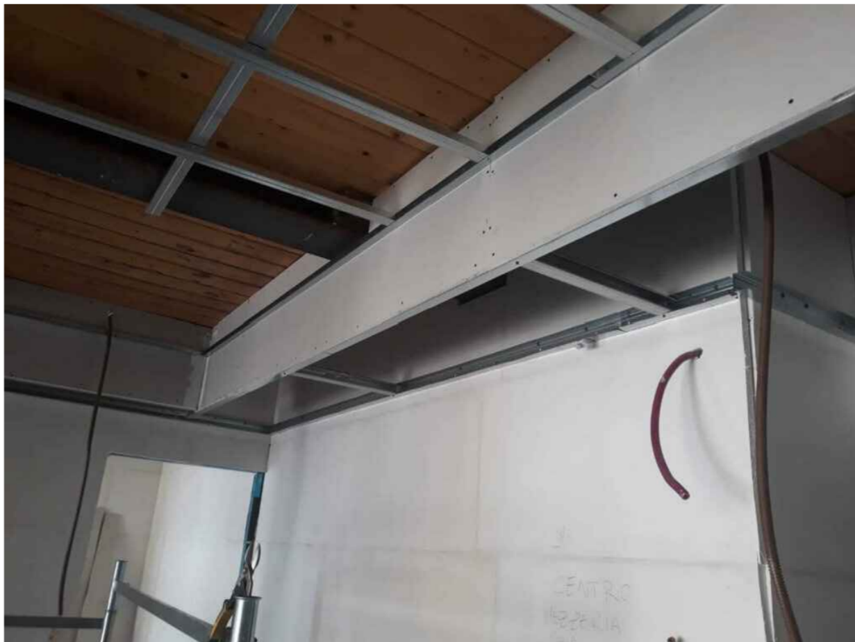
DETTAGLIO TIPICO REALIZZAZIONE VELETTA IN CARTONGESSO
