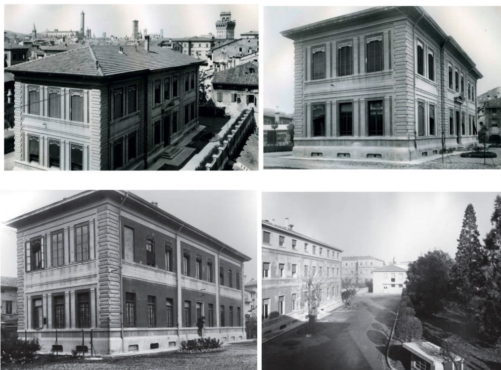
Fig. 7 Foto storiche dell'edificio e del comparto. Si osserva che l'edificio in esame era originariamente di soli due piani fuori terra, il piano secondo è stato oggetto di sopraelevazione durante gli anni '50.
