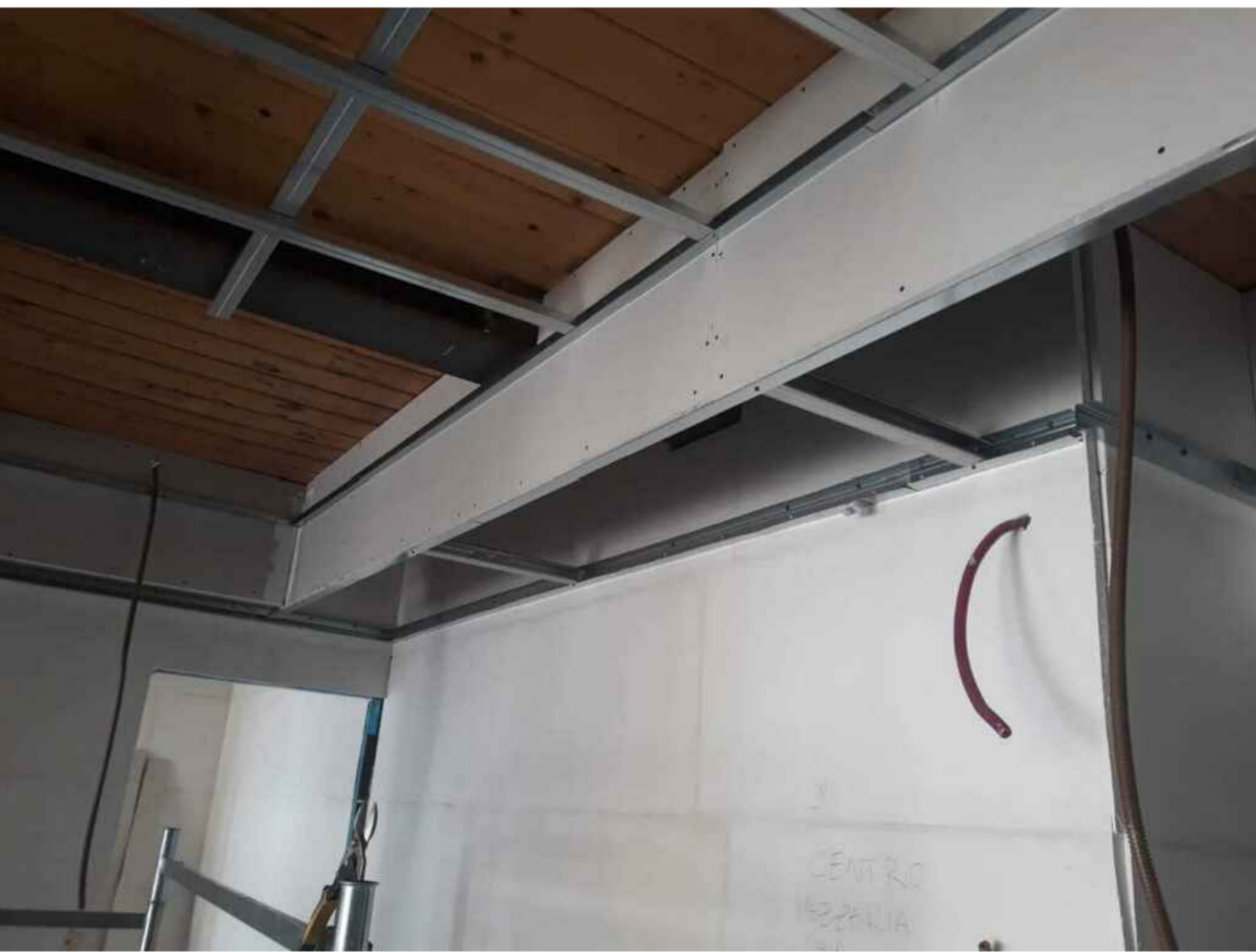
DETTAGLIO TIPICO REALIZZAZIONE VELETTA IN CARTONGESSO
