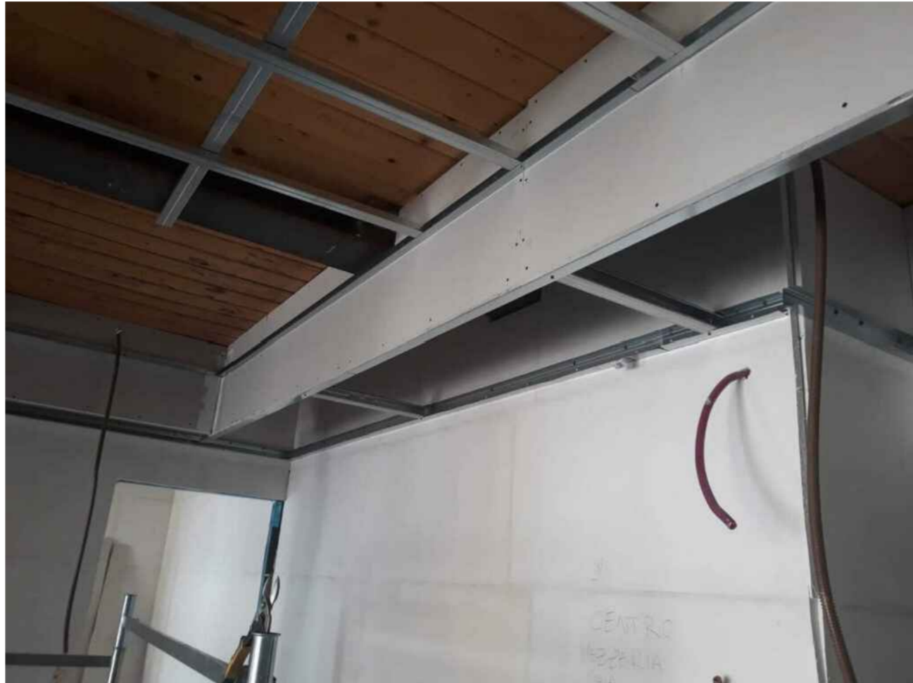
DETTAGLIO TIPICO REALIZZAZIONE VELETTA IN CARTONGESSO
